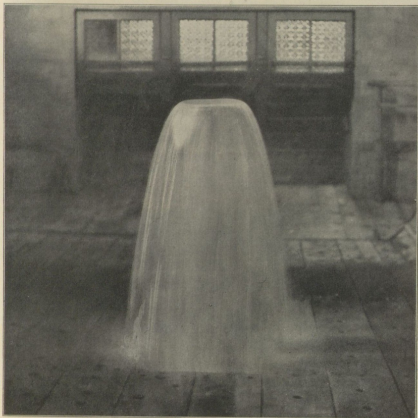
Die neue Quelle des Bades Nr. I, mit einer Ergiebigkeit von 3½ Millionen L. Heisswasser 38·6° C pro Tag.
