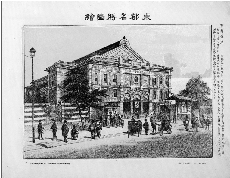
Abb. 7.11. Tōto meisho zue kabuki-za [Außenansicht des Kabuki-Theaters], mit freundlicher Genehmigung des Nationaltheaters Tokyo
